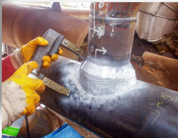
Inspeção por P.M
